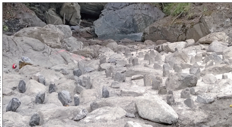
■ Protection de la conduite en amont du pont du Châtelet. Les pierres verticales au premier plan ont été cimentées intentionnellement dans cette position pour faciliter la remontée des truites...
